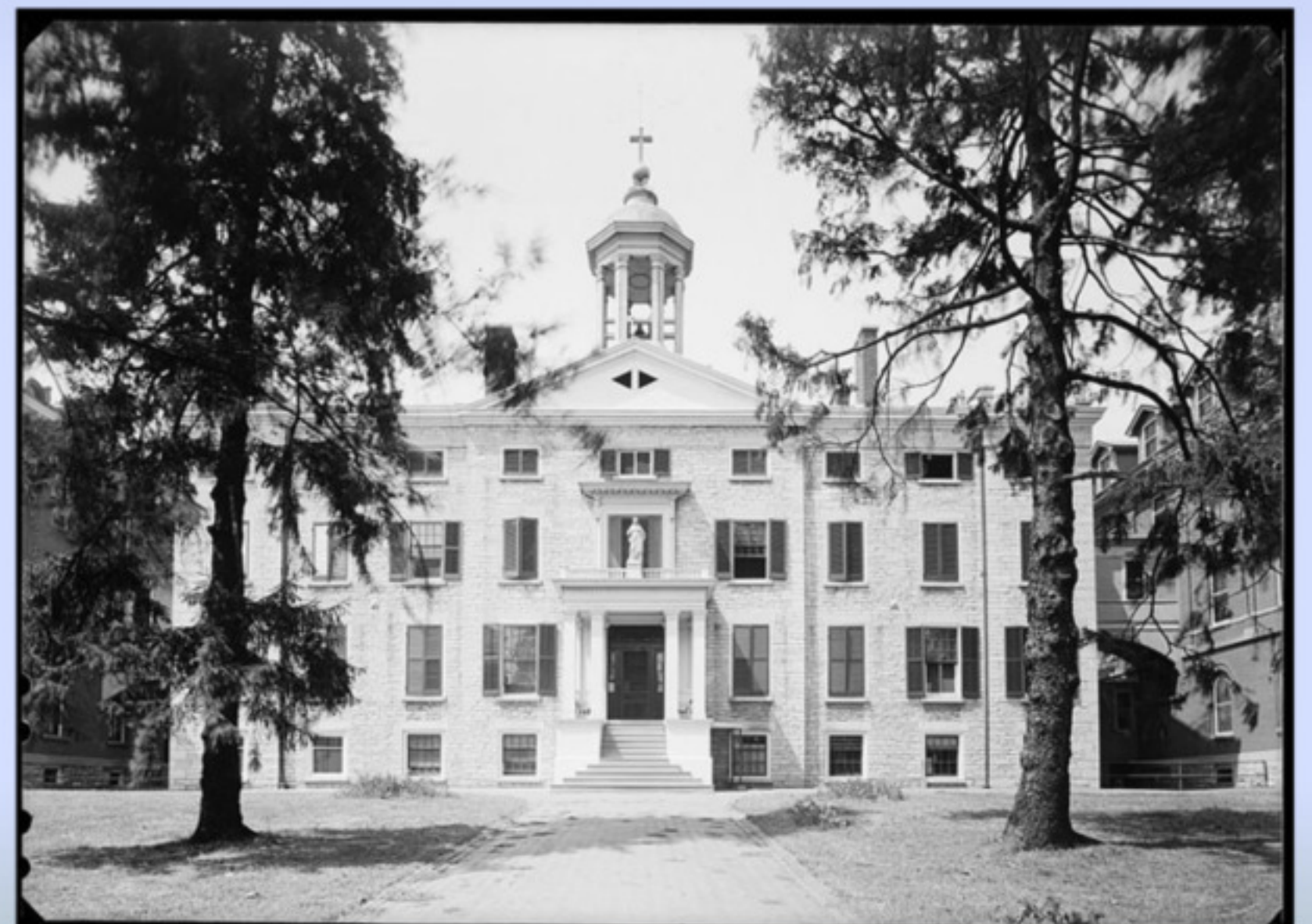
poi venne Rock Building (con Maria)
